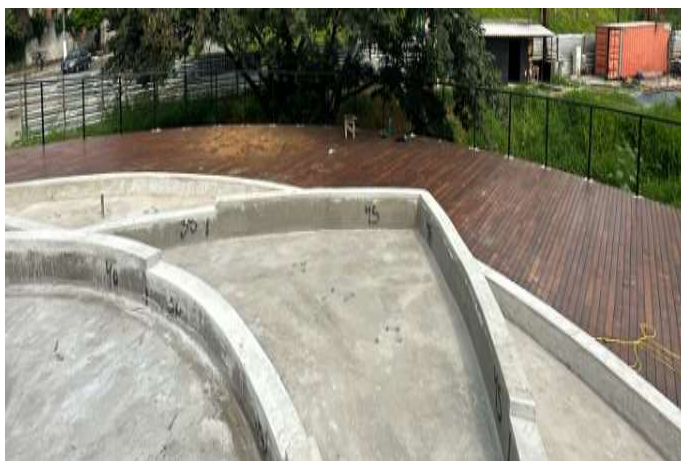
Foto. 7: Execução do contrapiso
