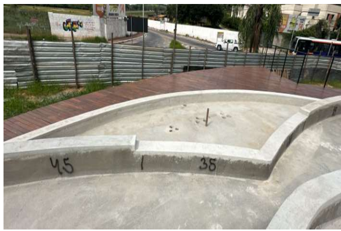
Foto. 8: Execução do contrapiso
