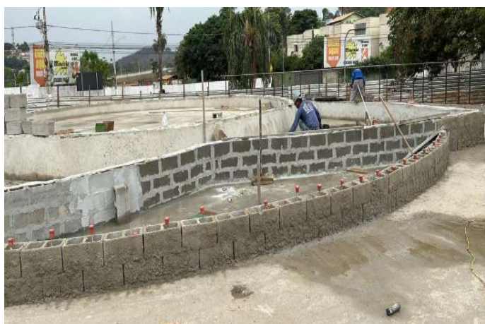
Foto. 9: Execução do chapisco da alvenaria
