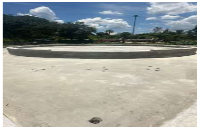
Foto. 10: Execução do reboco (emboço) da alvenaria
