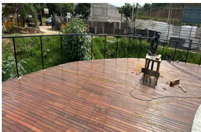
Foto. 4: Execução do deck de madeira
