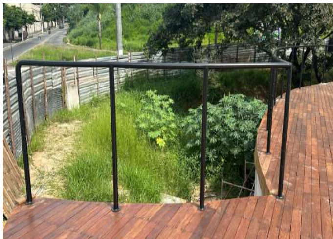
Foto. 1: Execução de guarda corpo
