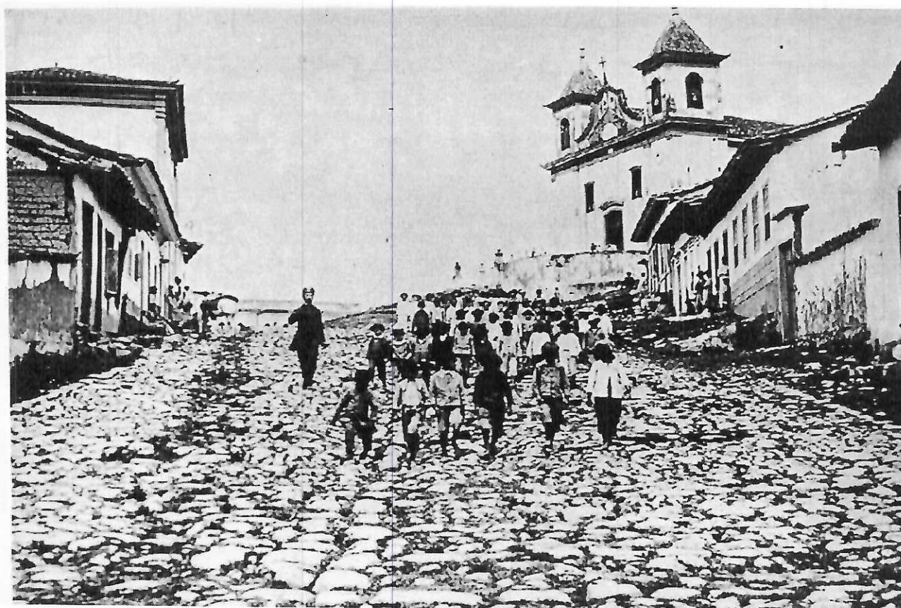
Figura 02 – Foto antiga da R. Direita de Santa Luzia, com a Matriz ao fundo. Autoria não identificada. Fonte: Acervo Memorial da Arquidiocese de Belo Horizonte/ Inventário do Patrimônio Cultural, s/d.
