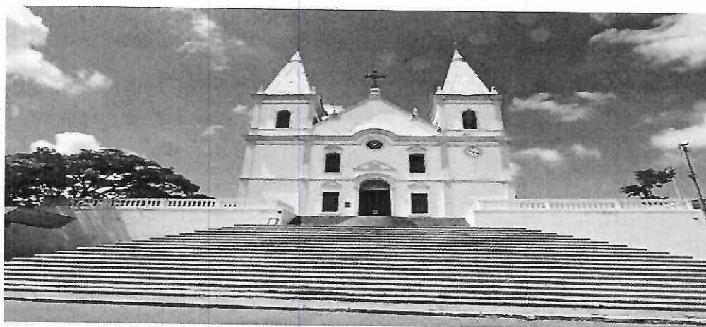
Figura 04 – Vista frontal da Igreja Matriz de Santa Luzia. Foto: Hebert G. S. Júnior, 2021. Fonte: Acervo Memorial da Arquidiocese de Belo Horizonte/Inventário do Patrimônio Cultural, 2021.
