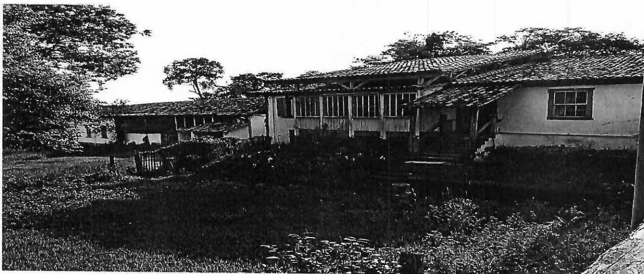
Fachada dos fundos da antiga fazenda Jaguará Velha, antes Santa Luzia do Rio das Velhas, atual Matozinho/MG)
